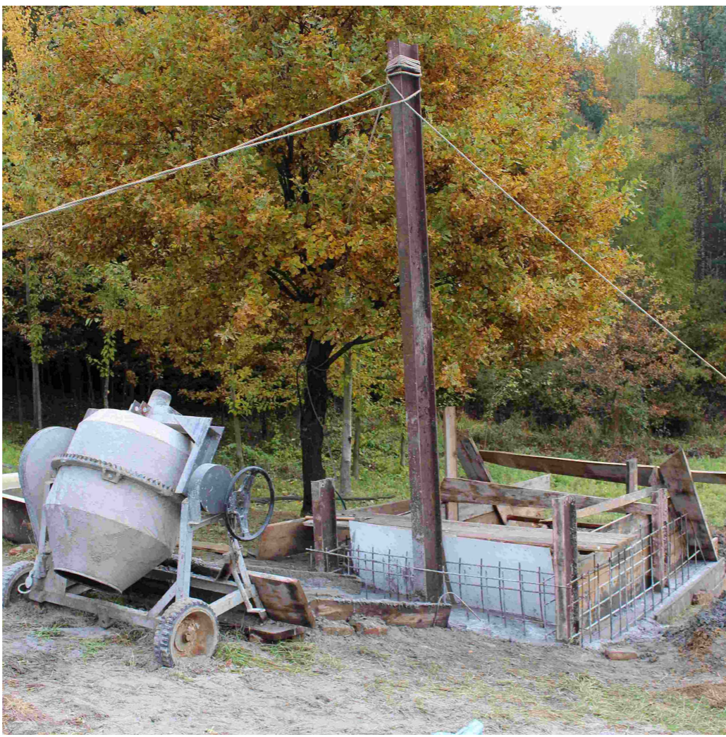
Wszystkie prace zostały wykonane własnym sumptem. Objętość żelbetonu wynosi 14 m 3 .
