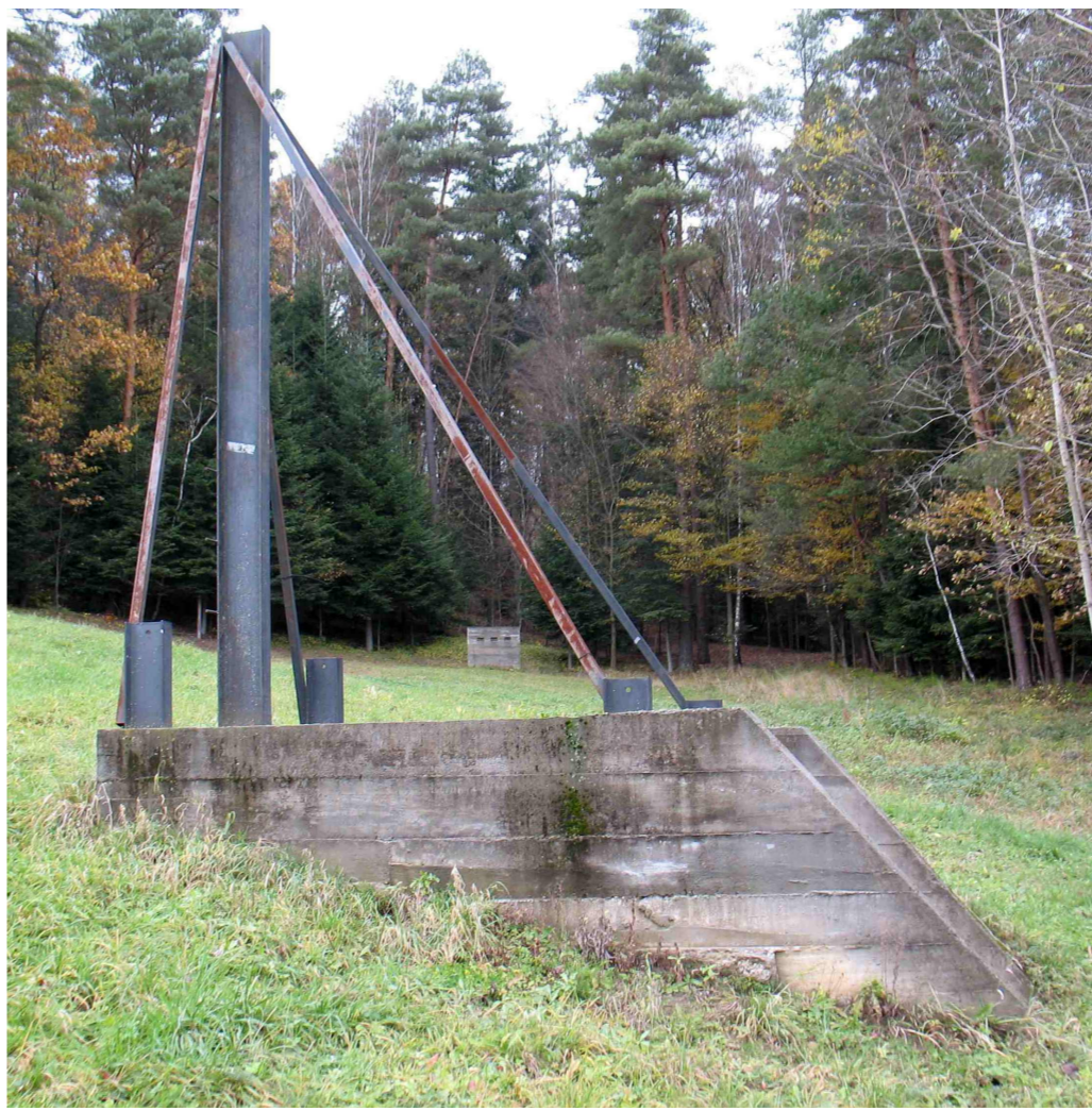
W bezpiecznej odległości od stanowiska testowego zbudowano również ścianę betonową z małymi otworami dla podglądu.
