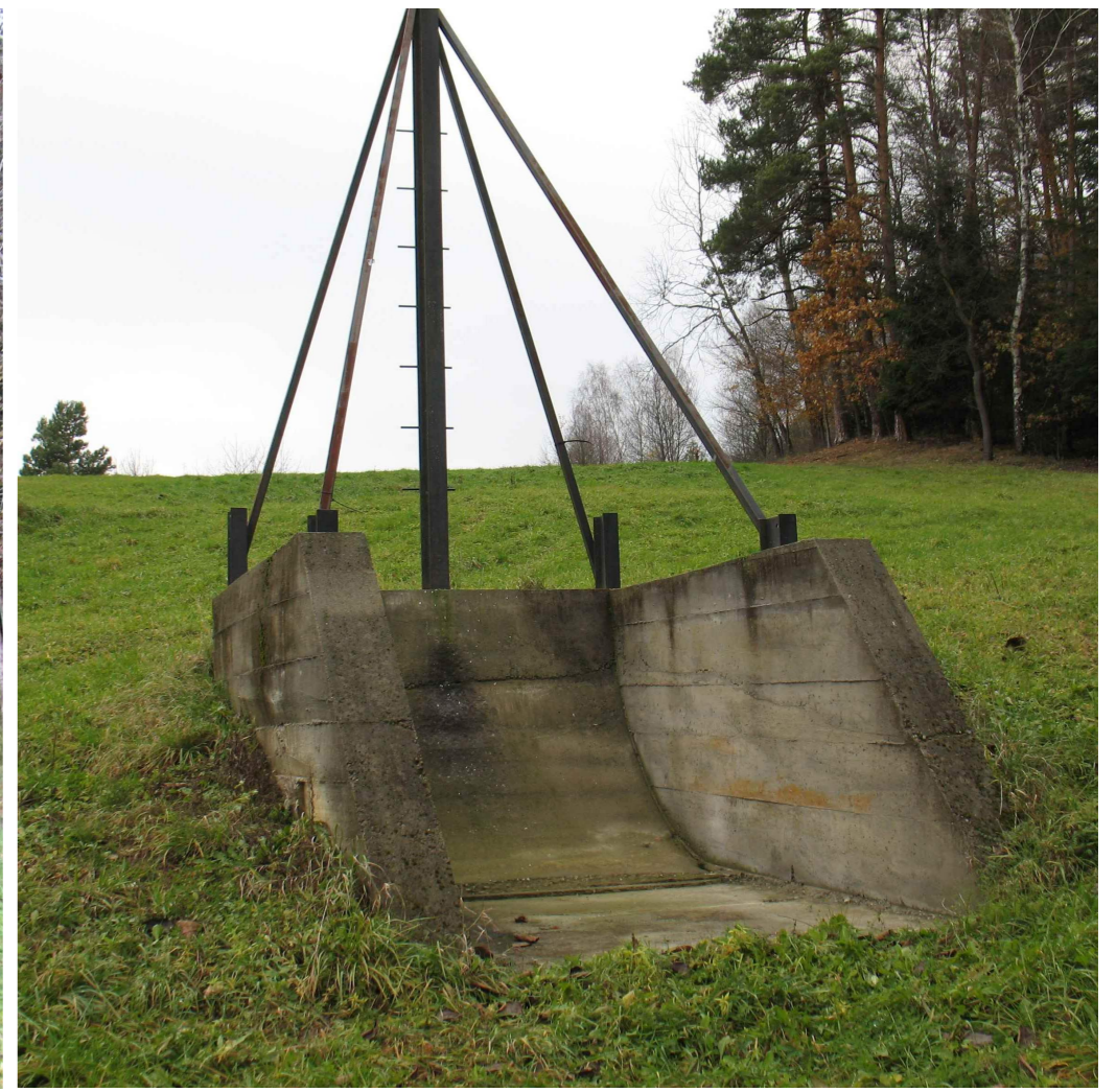
Silnik podpiną się do pionowego solidnego 2-teownika, a spaliny są wyrzucane w dół i odbijane od profilowanego dna.
