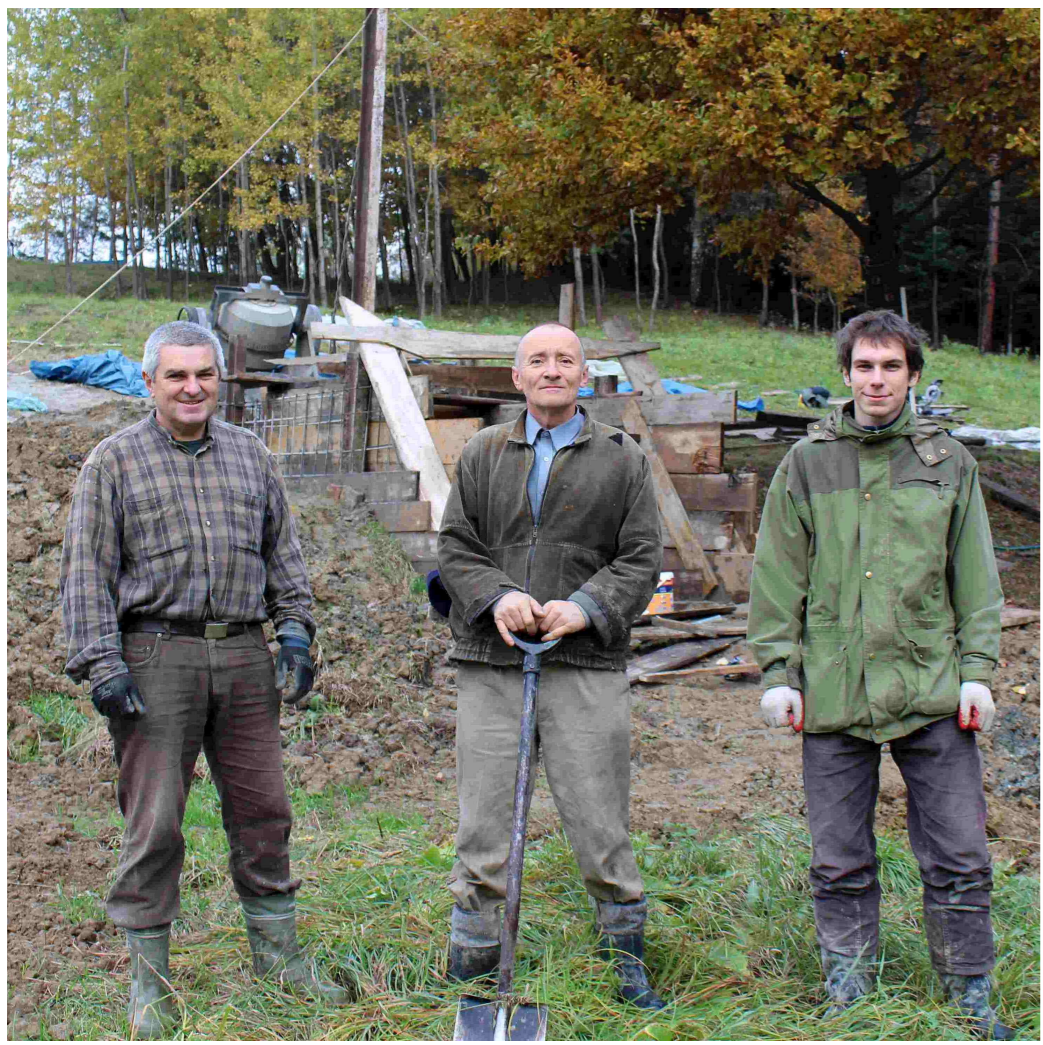
Koniec października 2015 roku. Budowa hamowni zgodnie z projektem Kacpra Zielińskiego. Od lewej: Wiesław Zieliński, Bogdan Wszolek i Kacper Zieliński.
